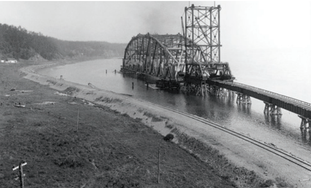
La seconde travée centrale est construite en moins de trois mois. Tirée par sept remorqueurs, elle quitte l'anse de Sillery le 17 septembre 1917.
