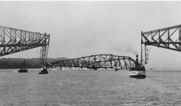
Effondrement de la travée centrale du pont de Québec.
