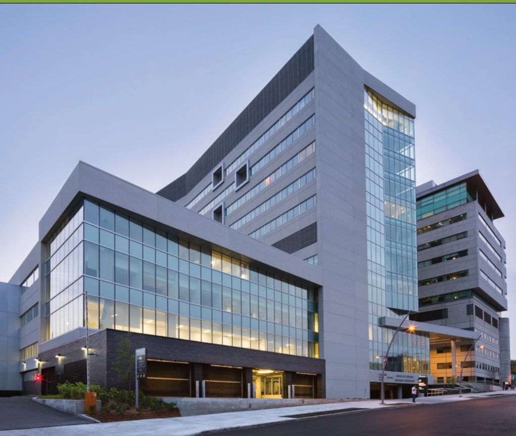
◀ Pavillon des soins critiques de l'Hôpital général juif, Montréal, Jodoin Lamarre Pratte + Gross Kaplin Coviensky + Marosi Troy Architectes en consortium Membre de l'équipe de conception et d'exécution : Jordi Jordana, architecte Photo : Stéphane Groleau
